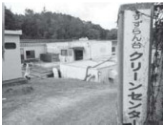
コミュニティプラント北部処理区
