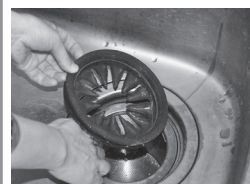
排水溝のごみを取り除く
