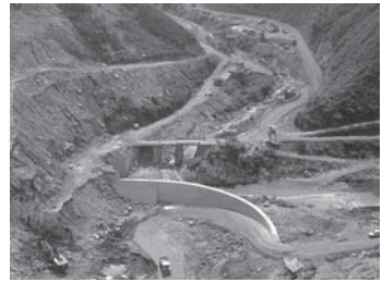
造成中の青蓮寺ダム(昭和41年ごろ)
