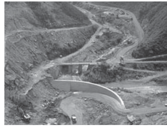
造成中の青蓮寺ダム(昭和41年ごろ)
