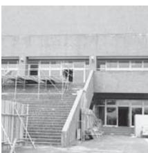
改修中の総合体育館
