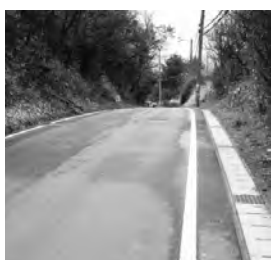
グリーン塗布される道路
