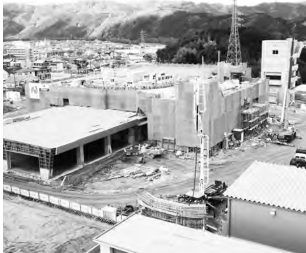
完成間近の新消防庁舎と防災センター
