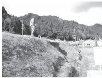
台風18号の被害
